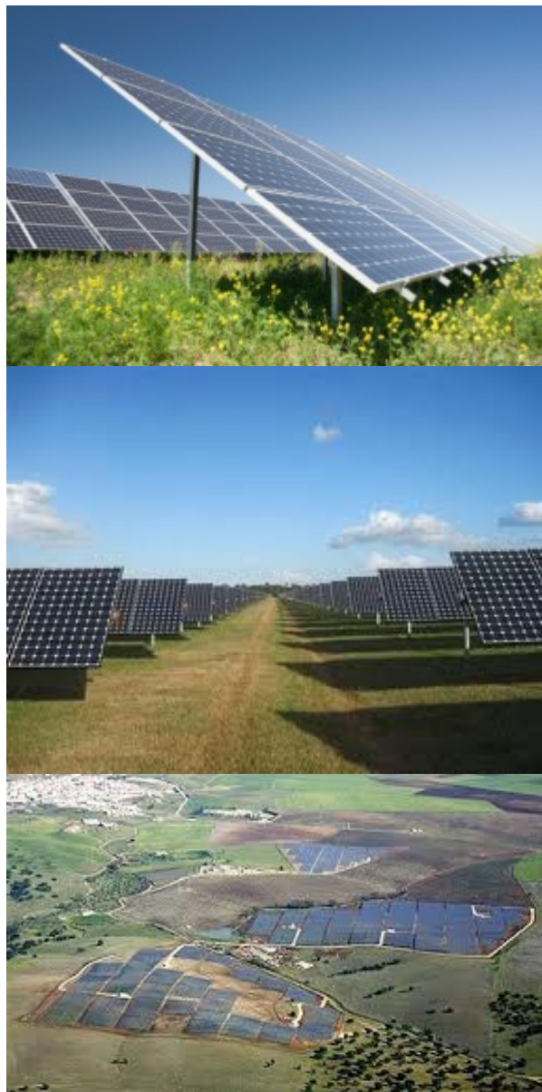
Zdjęcie 24 Przykładowe realizacje elektrowni słonecznych
