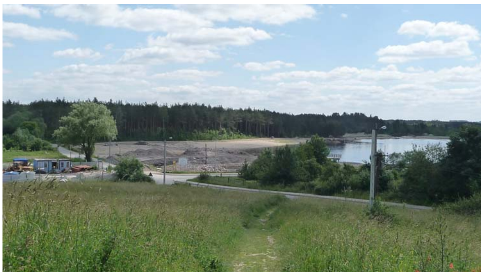
Fot. 2. Budowa zbiornika retencyjnego na Morawce w Morawicy.
