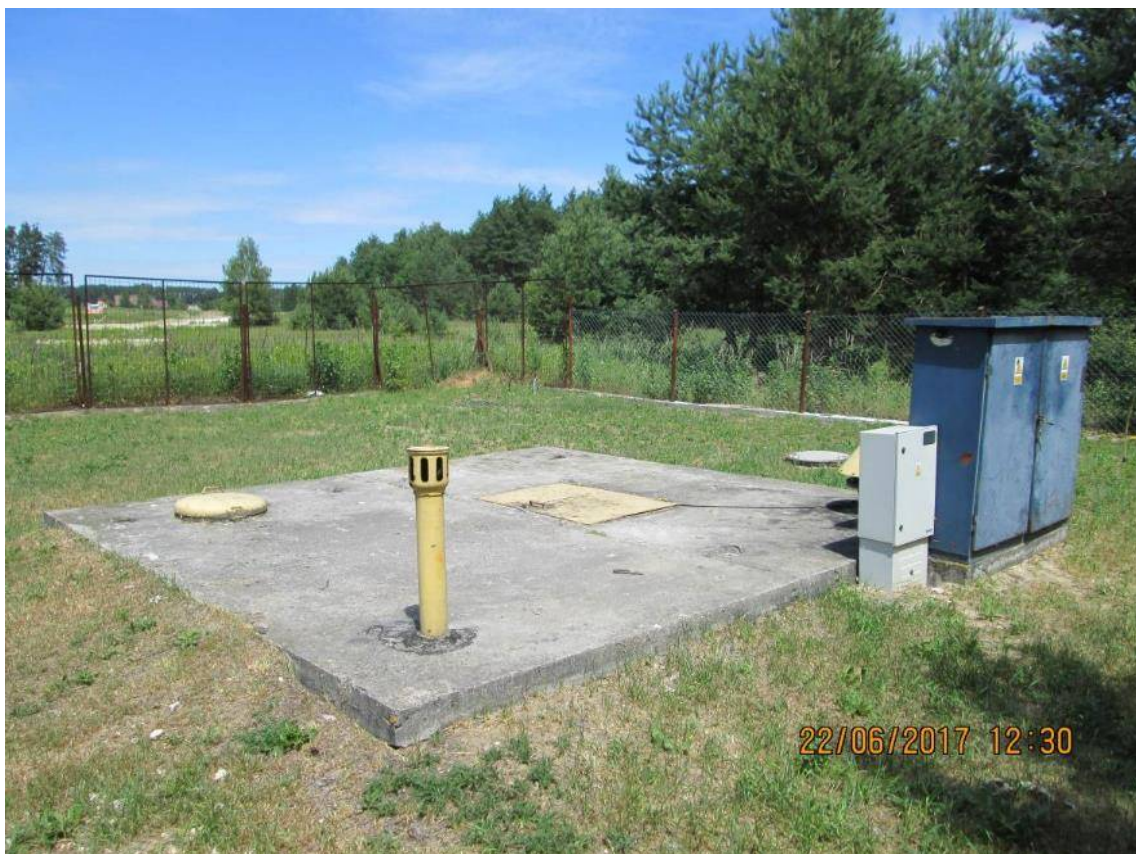
Zdjęcie 4Widok płyty stropowej pompowni „Zastawie 2”
