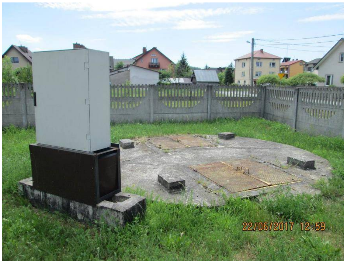
Zdjęcie 6 Widok płyty stropowej pompowni ścieków „Morawica 1”
