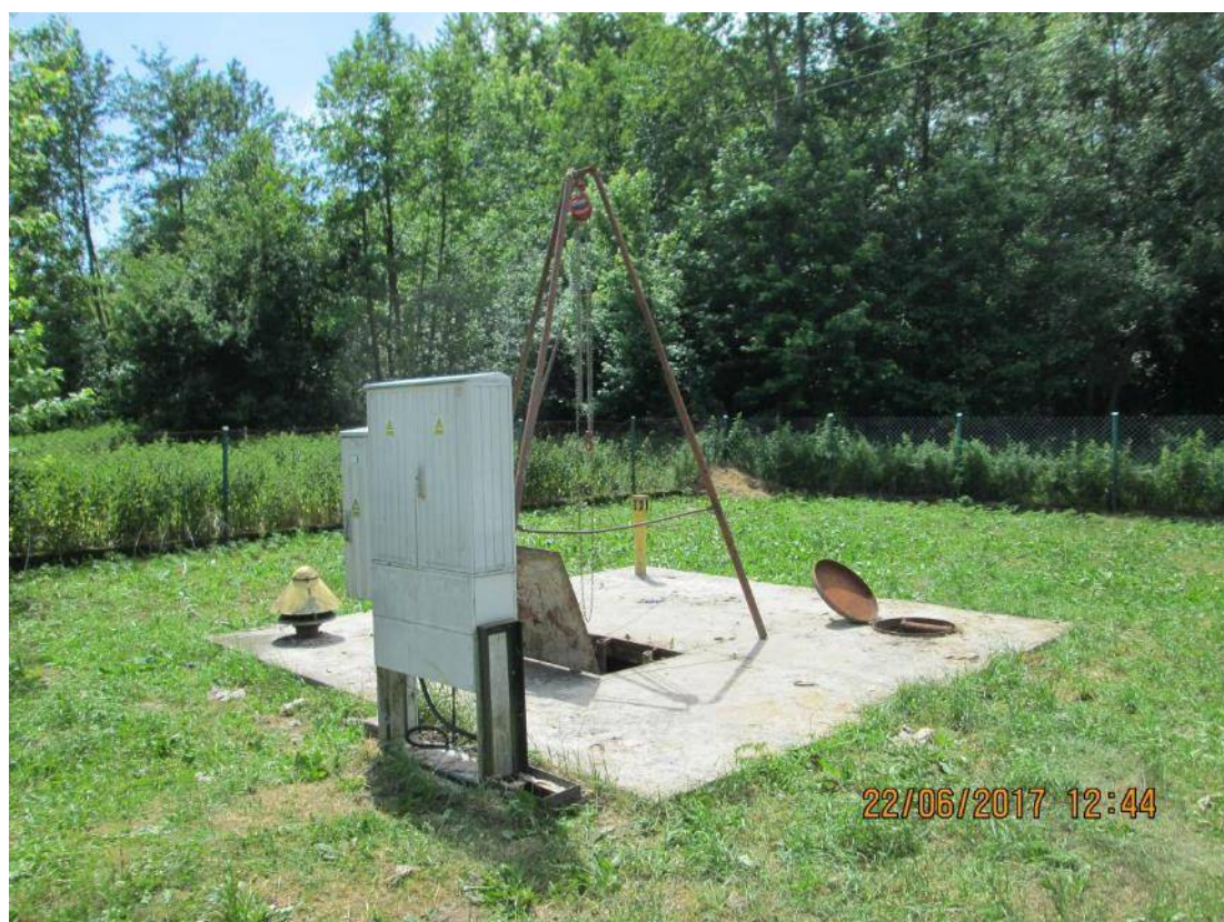
Zdjęcie 8Widok płyty stropowej pompowni ścieków „Bieleckie Młyny 1”
