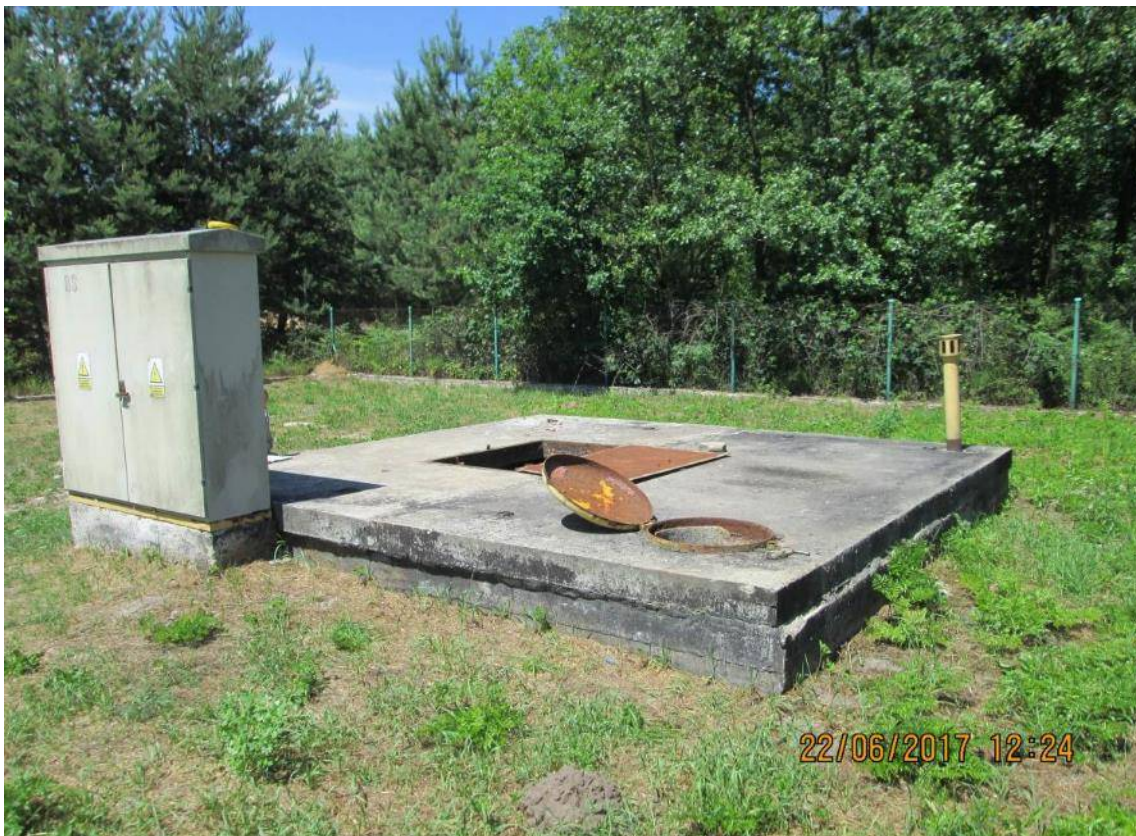
Zdjęcie 2 Widok płyty stropowej pompowni „Zestawie 1”
