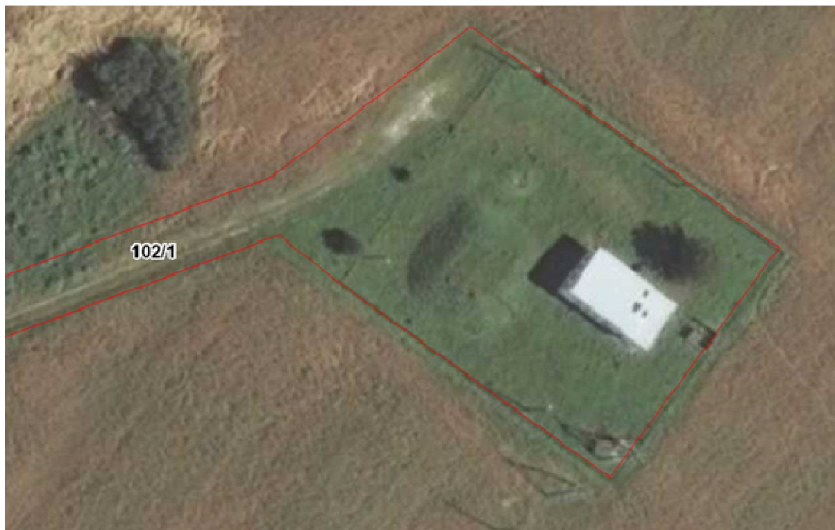
Rysunek 20 Lokalizacja instalacji fotowoltaicznej na budynku hydroforni w Dębskiej Woli (dz. nr 102/1)
